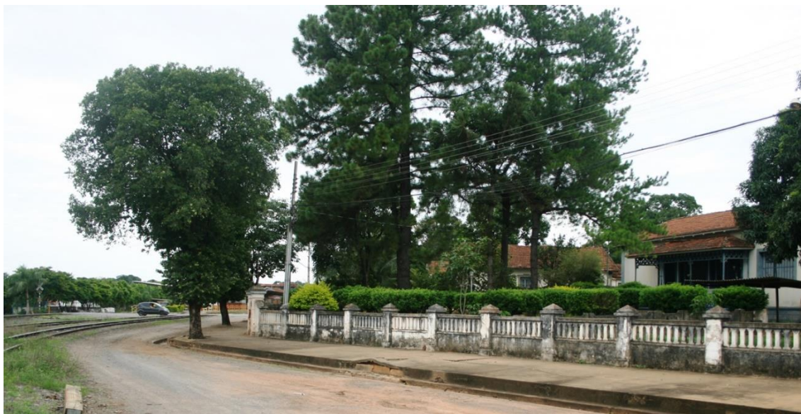
Figura 8: Pátio da Estação: casas dos engenheiros
