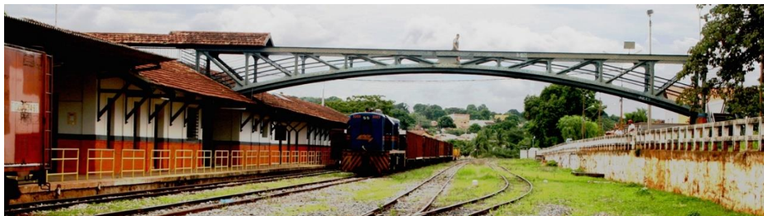
Figura 7: SETOR 01: Estação, com passadiço
