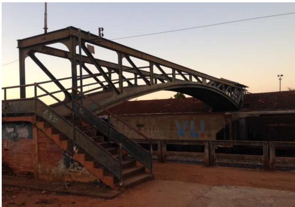
Figura 15: Passadiço e estação: situação atual
